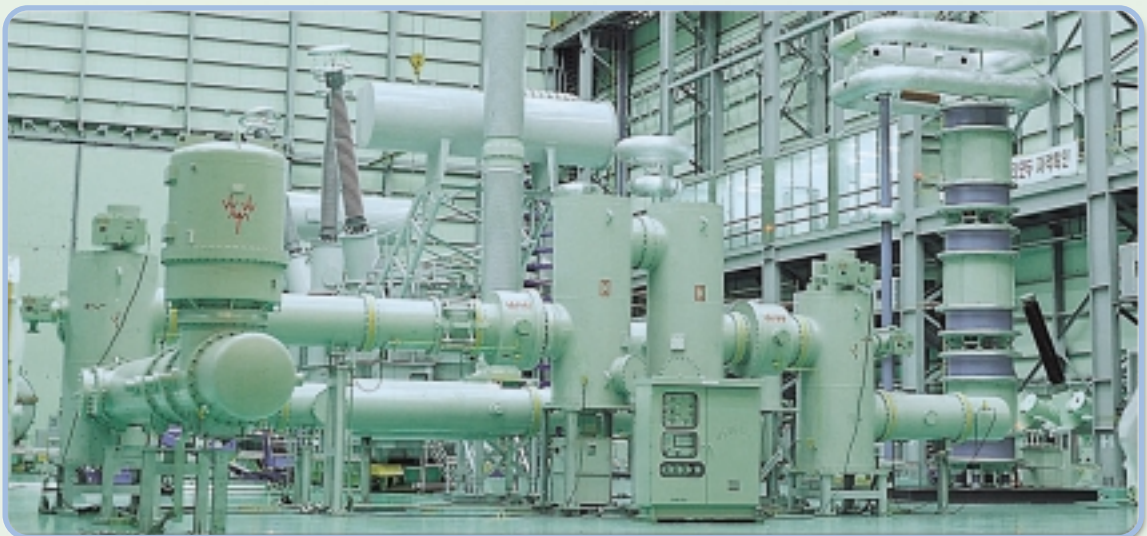
800 kV 50 kA GIS
