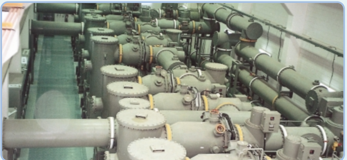
145 kV 40 kA GIS
