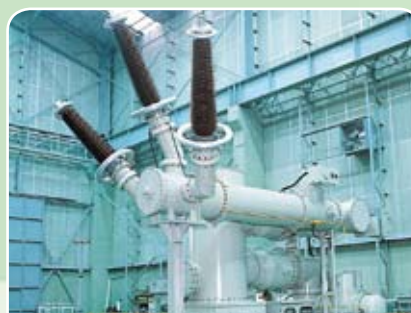
Испытательные воздушные вводы
