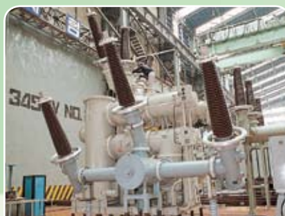
Заводские испытания КРУЭ 145кВ 40кА
