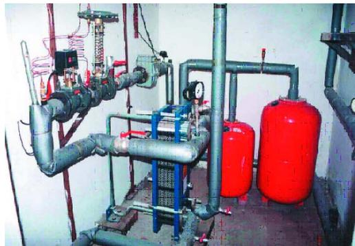
Рис. 26. Автоматизированный тепловой пункт
